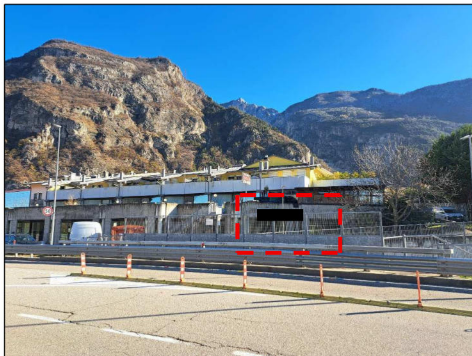
FOTO 02: frangente sud del prospetto ovest della p.ed. 918 – evidenza del sub. 12 P.M. 10.
