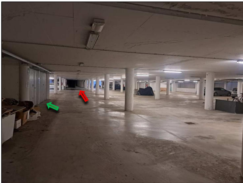
FOTO 34: autorimessa a piano sottostrada. Evidenza della discenderia nord (rosso) e del posto macchina esclusivo della P.M. 10 (verde). Presa da sud.
