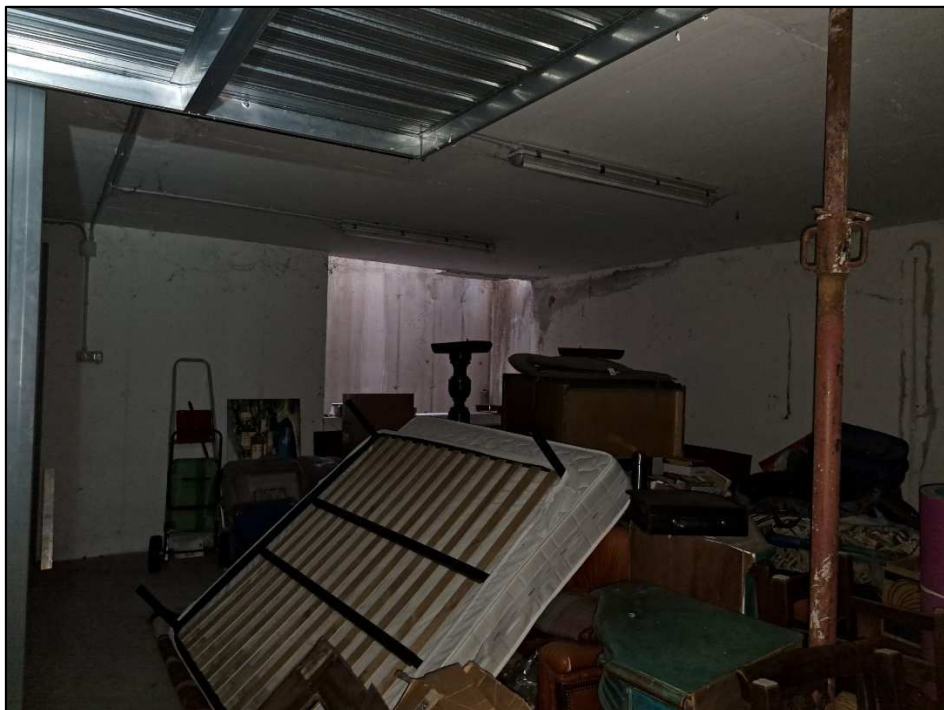
FOTO 36: posto macchina esclusivo della P.M. 10, con apertura su bocca di lupo. Presa da nord-est.
