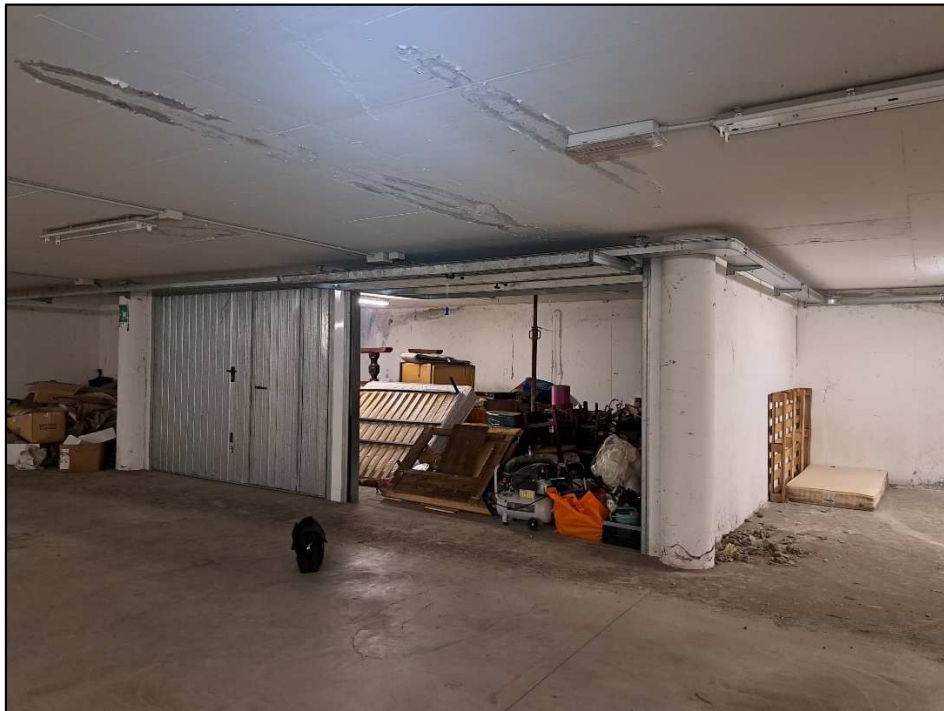
FOTO 35: posto macchina esclusivo della P.M. 10, dotato di portoni basculanti. Presa da est.
