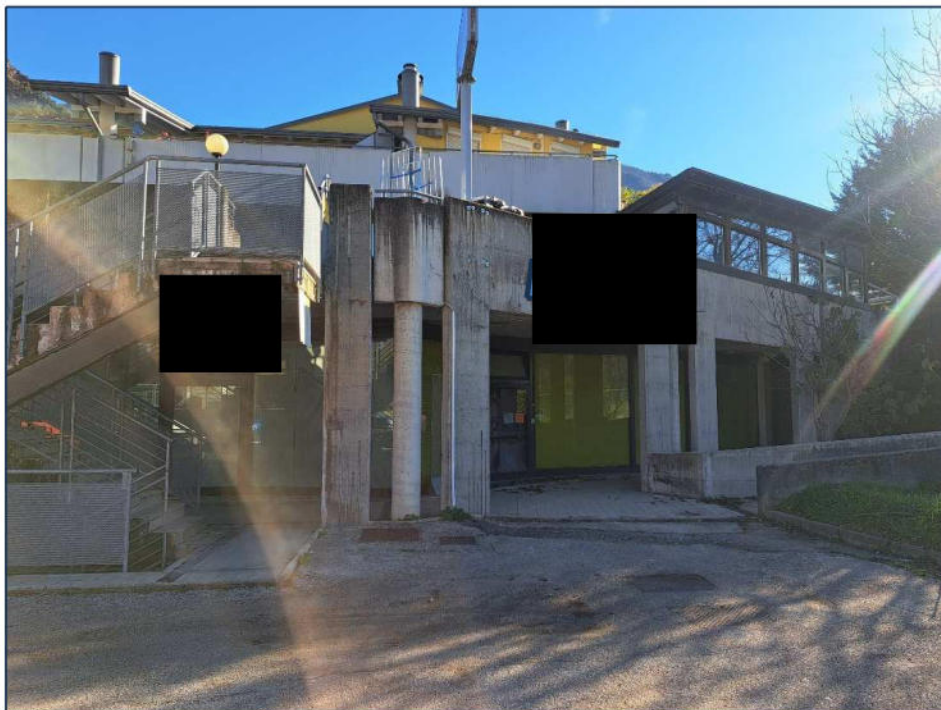
FOTO 12: frangente sud del prospetto ovest. Ingresso e vetrine del sub. 12 P.M. 10.
