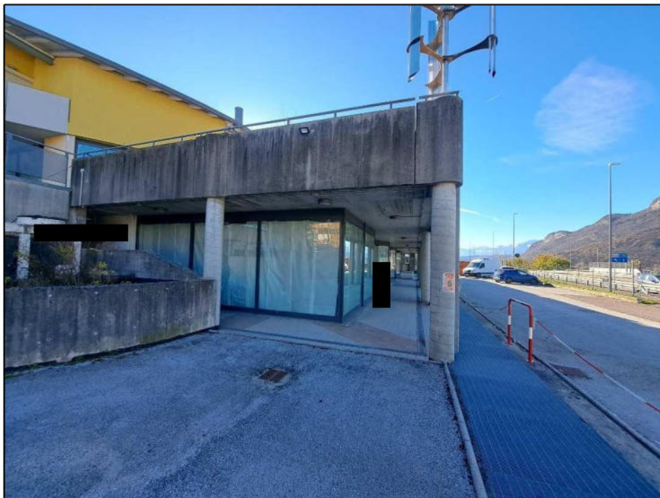
FOTO 07: porticato e cortile ovest a piano strada.
